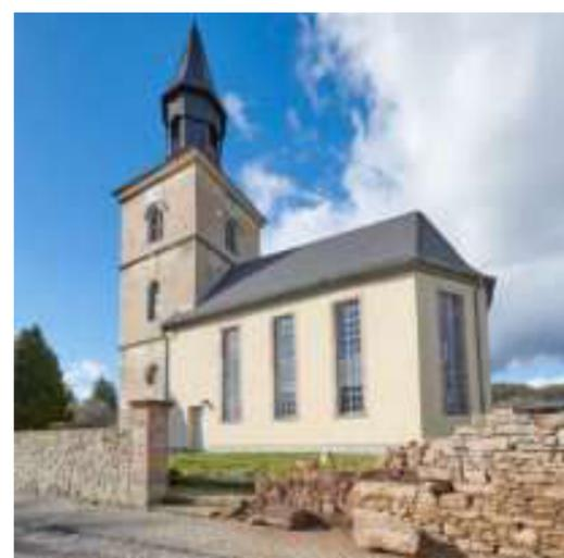
Ältere Sonderbauten, in Naturstein massiv gemauert + tw. verputzt
